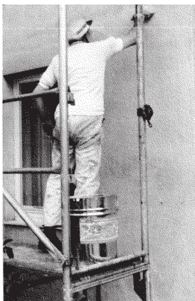
Auf die eingerüstete Fassade wird Dispersions-Farblöser dünn aufgetragen
